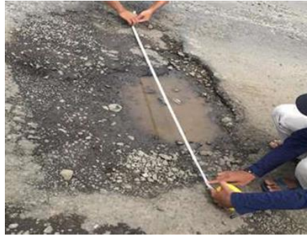
Gambar 3. Kerusakan berupa lubang
