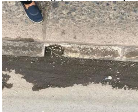
Gambar 5. Saluran air yang tersumbat
