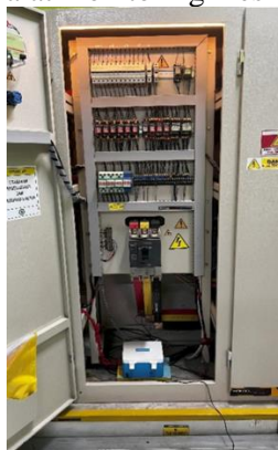
Gambar 9. Penempatan box monitoring di panel ATS
