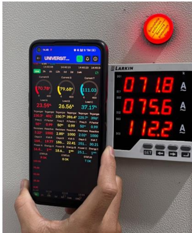
Gambar 2. Perbandingan display panel dengan monitoring arus
