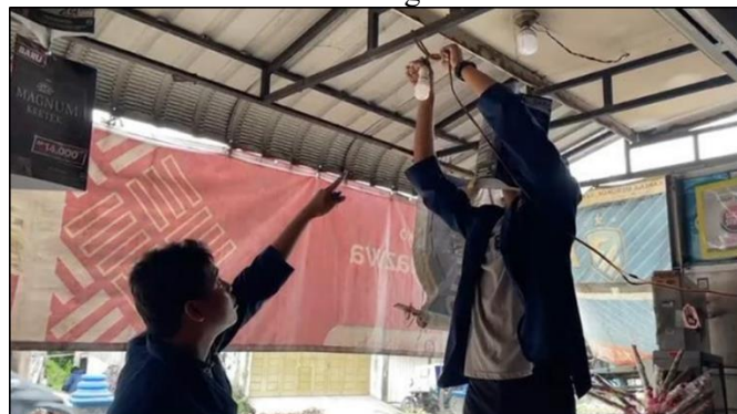
Gambar 13. Pemasangan Lampu di Toko
