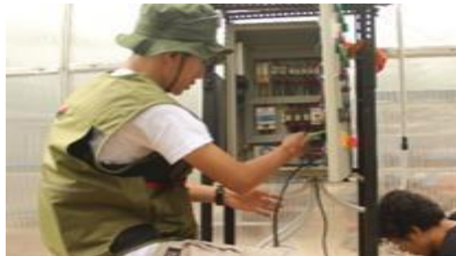
Gambar 4. Proses pemasangan panel hybrid PLTS
