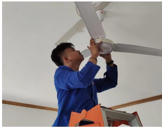
Gambar 6. Perakitan dan pemasangan kipas angin
