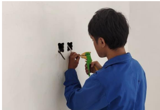
Gambar 4. Pemasangan saklar dan stop kontak
