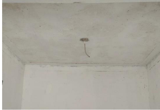
Gambar 2. Titik lampu tempat imam sebelum terpasang fitting lampu.
