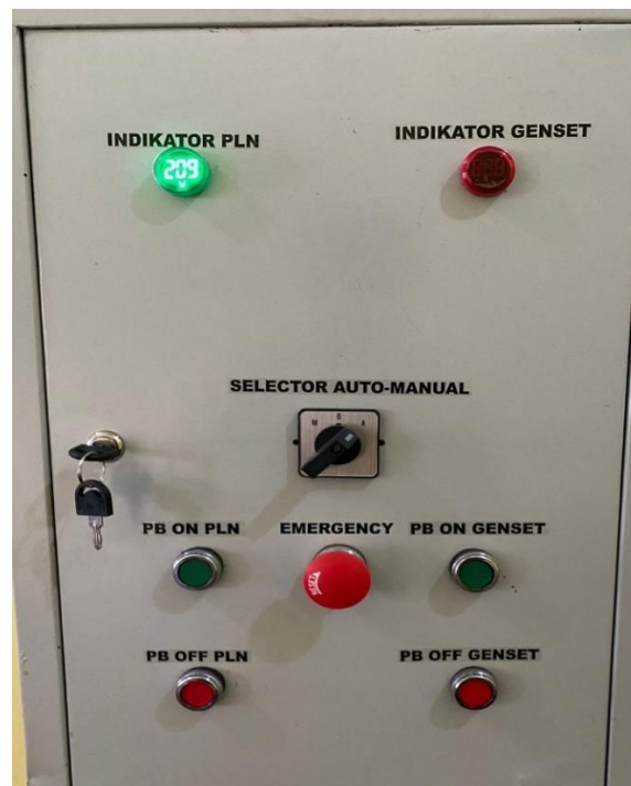
Gambar 2. Casing Box Pada ATS - AMF
