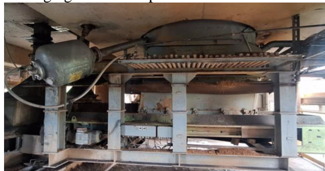
Gambar 15. Lokasi penambahan AB Baru
