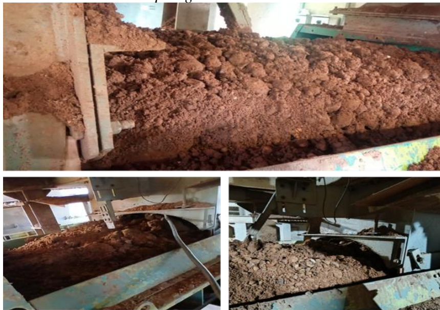
Gambar 16. Memonitor kondisi WF setelah perbaikan Sumber: Dokumentasi pribadi
