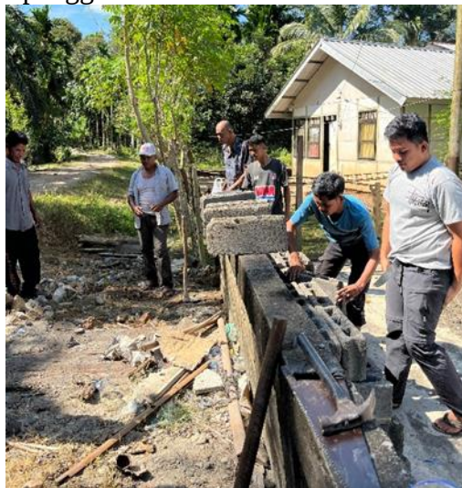
Gambar 1. Proses penyusunan bata dan pembentukan ruang bakar rocket stove di Desa Gle Putoh.
