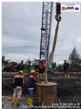
Gambar 2. Pemasangan selongsong PDA
